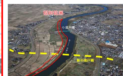
河道掘削（国）・小須戸橋架替（国・市）
