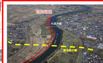
河道掘削(国)・小須戸橋架替(国・市)
