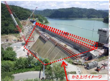
ダム建設・ダム再生
