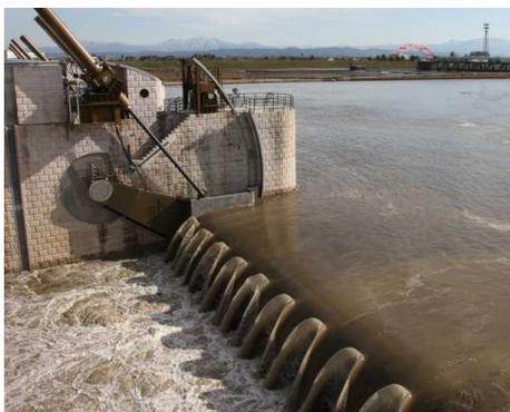
普段、可動堰は信濃川下流の生活用水などを確保するため、大河津分水路に水が流れすぎないように流量を調節しています。
