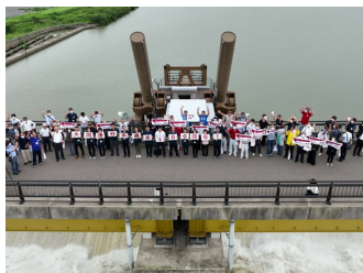
可動堰オープン
