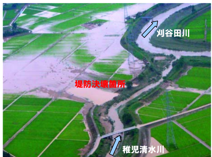
堤防が決壊した稚児清水川。濁水は下流へと流れ下った。
