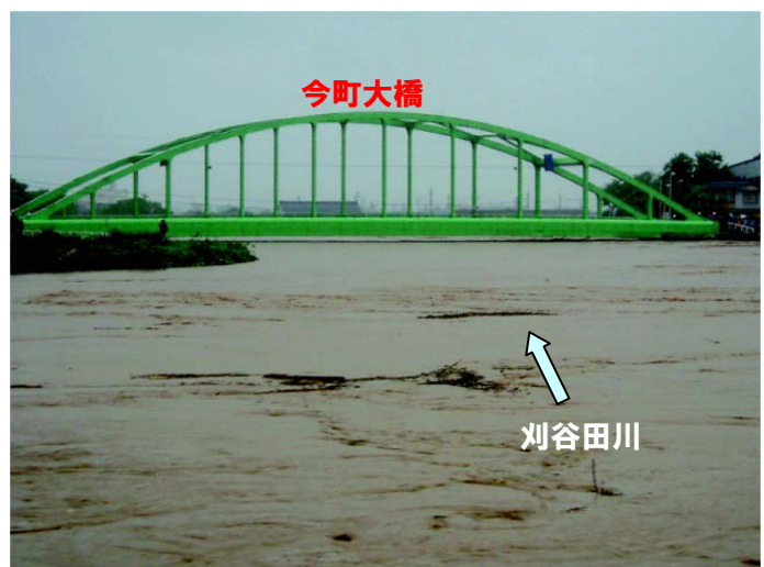
堤防決壊前の刈谷田川。橋桁すれすれまで水位が上昇。
