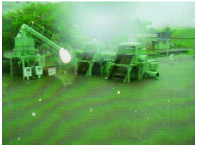
見附市葛巻の下水処理場も浸水した。
