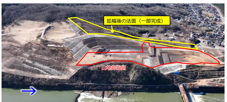
山地部掘削の状況 (撮影日: 令和8年2月26日)
