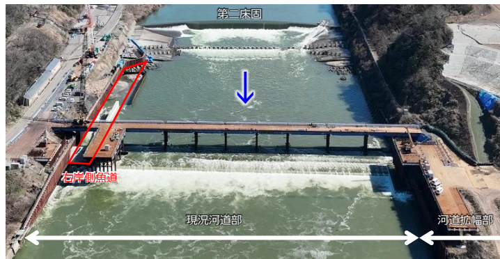
新第二床固 現況河道部の状況 (撮影日: 令和8年2月26日)
