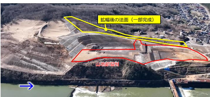
山地部掘削の状況 (撮影日: 令和8年2月26日)
