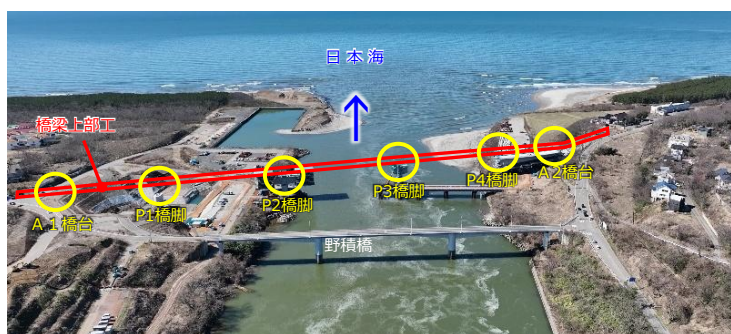
新野積橋(仮称) 架替施工の状況 (撮影日: 令和8年2月26日)
