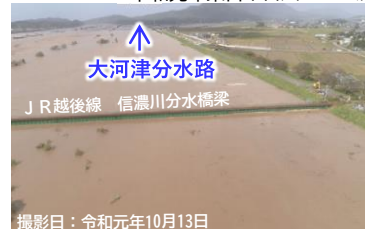
撮影日：令和元年10月13日 J R越後線 信濃川分水橋梁付近 （洪水により橋梁桁下付近まで水位が上昇）
