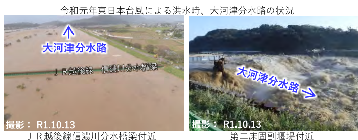
令和元年東日本台風による洪水時、大河津分水路の状況 撮影：R1.10.13 J R越後線 信濃川分水橋梁付近
