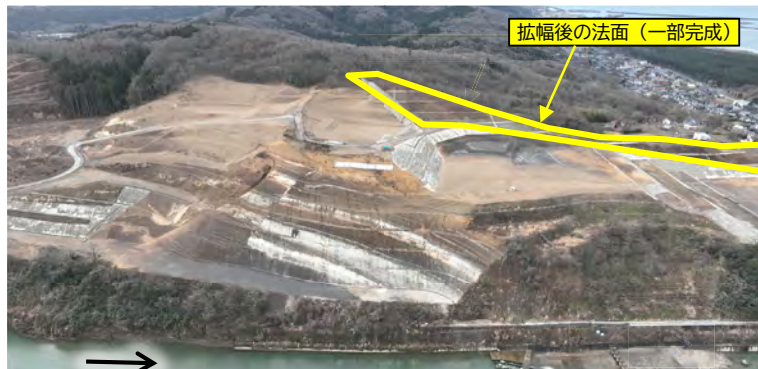
山地部掘削の状況 (撮影日：令和6年2月29日)
