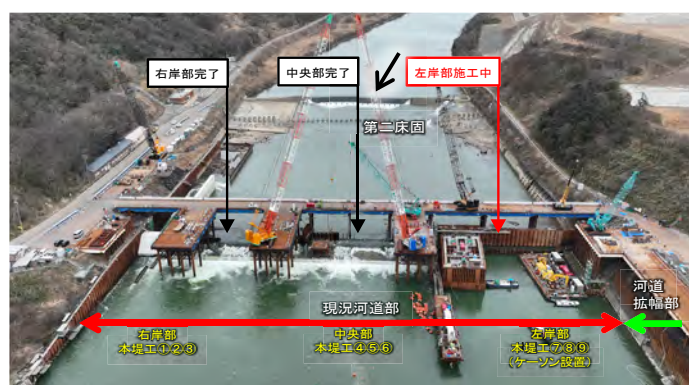
新第二床固 鋼殻ケーソン (PM7~9) 据付・設置の状況 (撮影日：令和6年2月29日)
