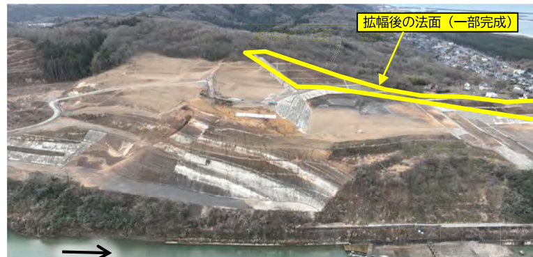
山地部掘削の状況 (撮影日：令和6年2月29日)
