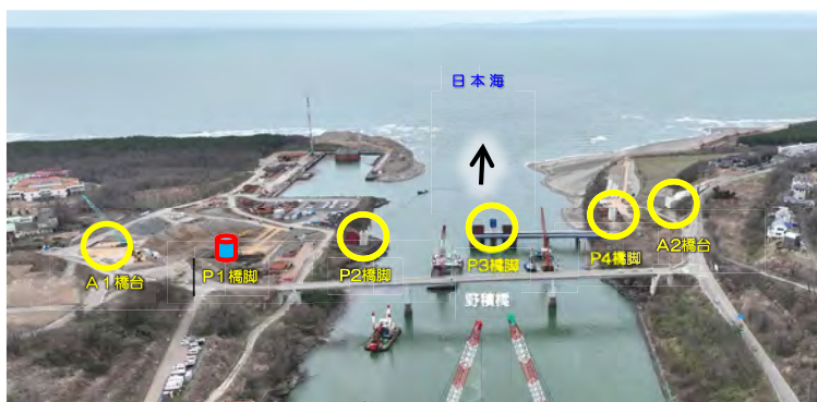
新野積橋 (仮称) 施工の状況 (撮影日：令和6年2月29日)
