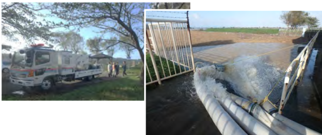
新黒川水門 ポンプ車による排水状況 (R1.10.13)
