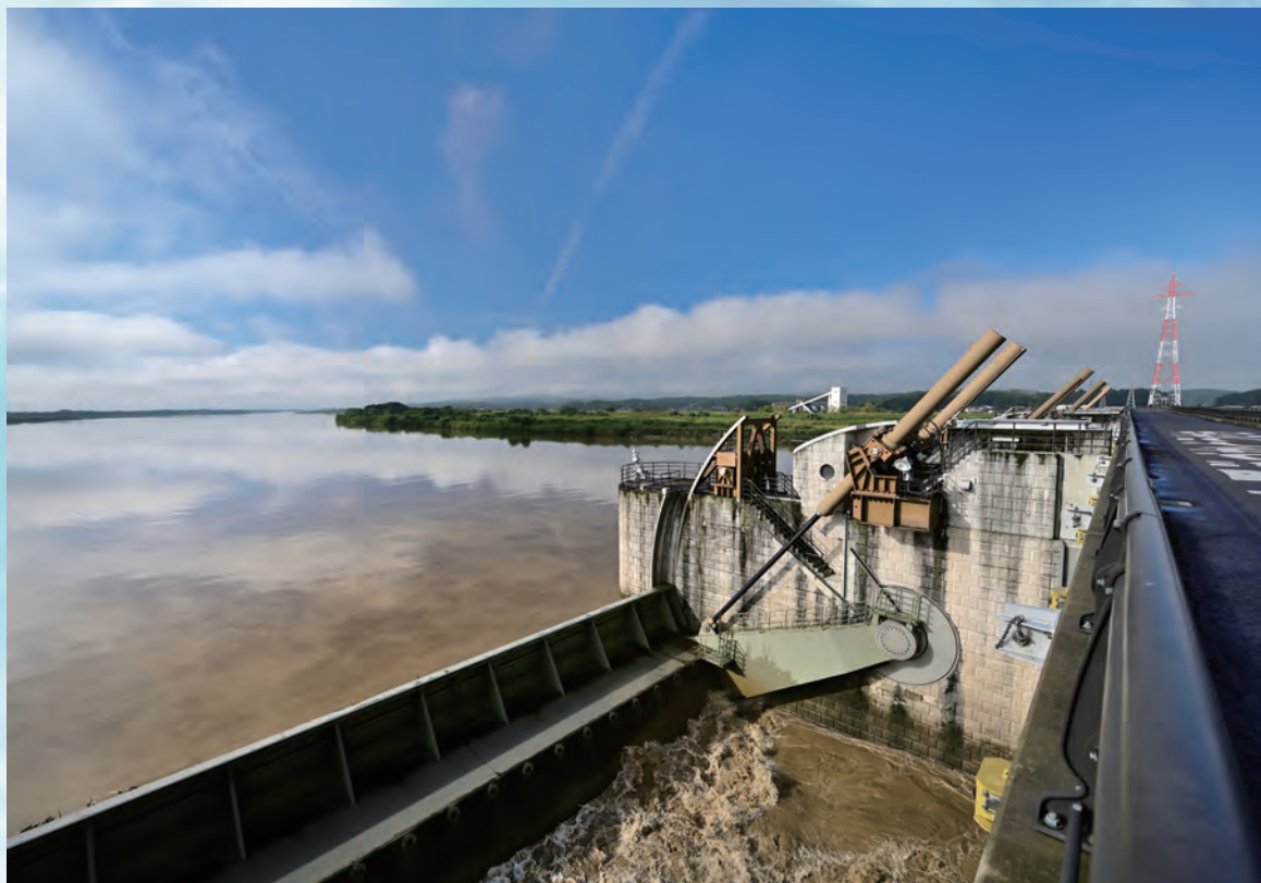
大河津分水部門 新潟日報社賞【撮影地：大河津分水 可動堰】
