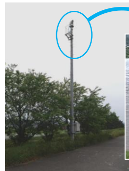
CCTVカメラ設置状況
