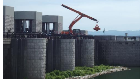
大河津洗堰 漂着流木等の撤去状況
