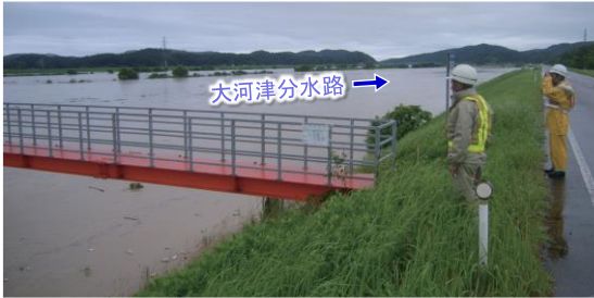
出水時巡視状況（大河津出張所管内）
