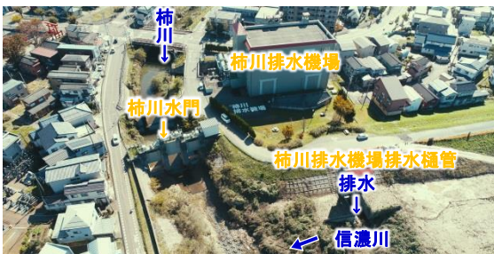
柿川排水機場
