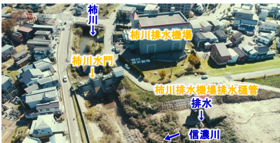
柿川排水機場
