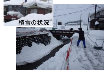
導入後の状況（令和2年12月） （堀之内消流雪用水導入施設）
