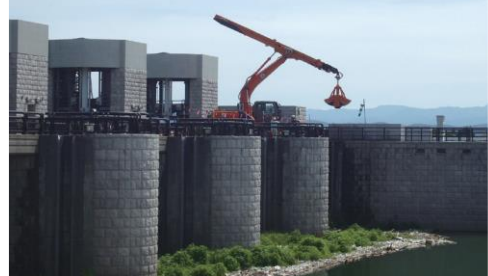
大河津洗堰 漂着流木等の撤去状況
