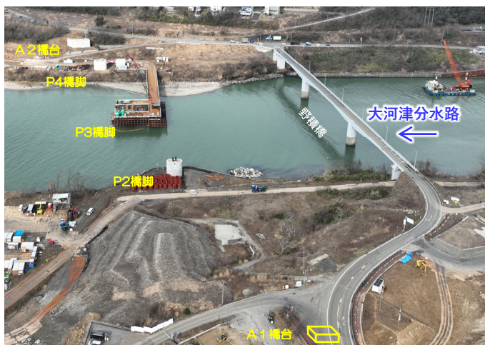
新野積橋 (仮称) P3橋脚本体、A1橋台施工の準備工事状況 (撮影日：令和4年3月2日)
