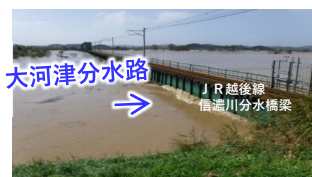
J R越後線信濃川分水橋梁の橋桁まで達した出水の状況 (R元年台風第19号時)
