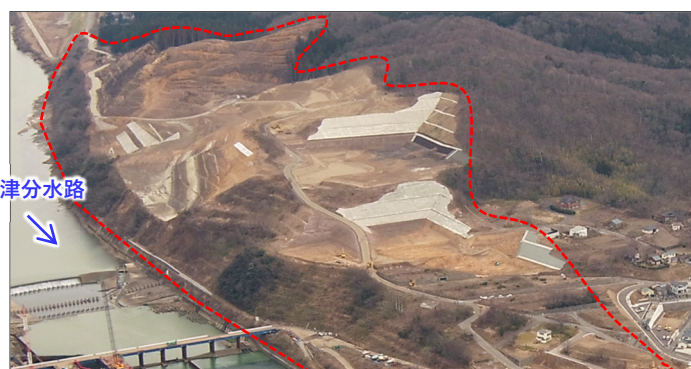
山地部掘削の工事状況 (撮影日：令和4年3月2日)
