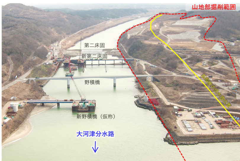
河口付近の工事状況 (撮影日：令和4年3月2日)
