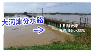
J R越後線信濃川分水橋梁の橋桁まで達した出水の状況 (R元年台風第19号時)
