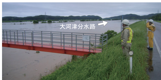
出水時巡視状況（大河津出張所管内）
