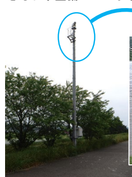
CCTVカメラ設置状況
