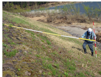
堤防等点検状況
