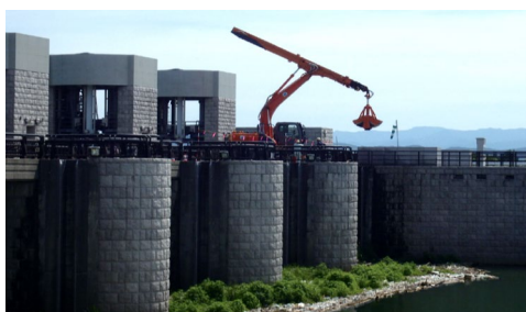
大河津洗堰 漂着流木等の撤去状況
