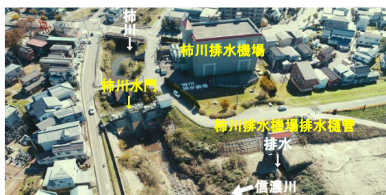
柿川排水機場
