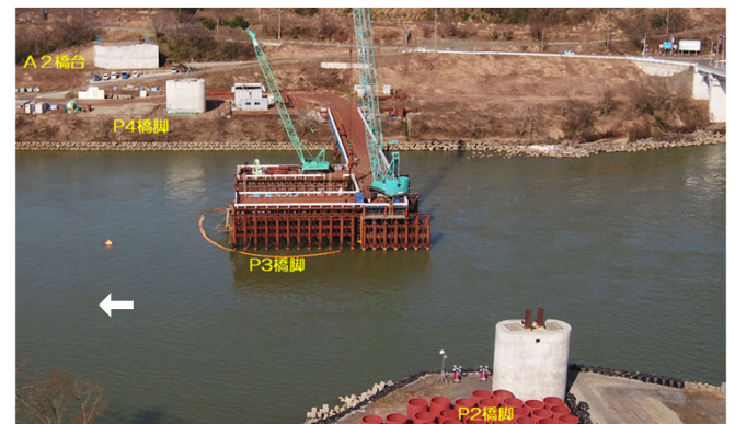
新野積橋（仮称）P3橋脚本体の工事状況（撮影日：令和3年3月4日）
