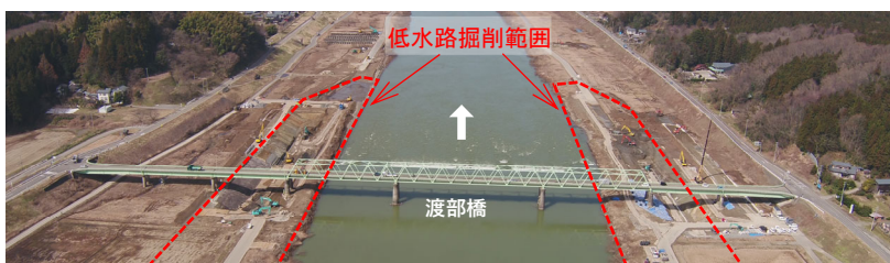
低水路掘削（渡部地区）の工事状況（撮影日：令和3年3月4日）
