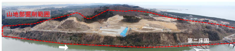
山地部掘削の工事状況（撮影日：令和3年3月4日）
