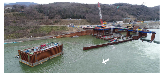
新第二床固鋼殻ケーソン（PM3）移動作業の状況（撮影日：令和3年3月8日）
