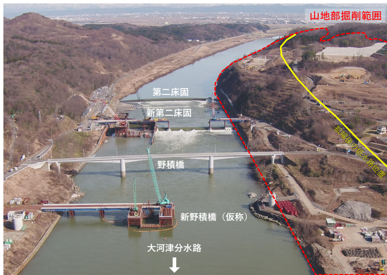
河口付近の工事状況（撮影日：令和3年3月4日）
