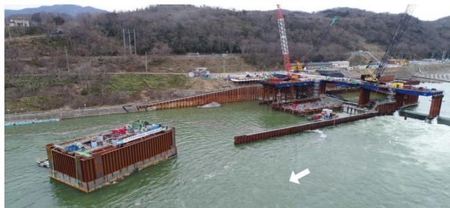
新第二床固鋼殻ケーソン（PM3）移動作業の状況（撮影日：令和3年3月8日）
