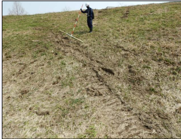
堤防法面の点検（長岡出張所管内）
