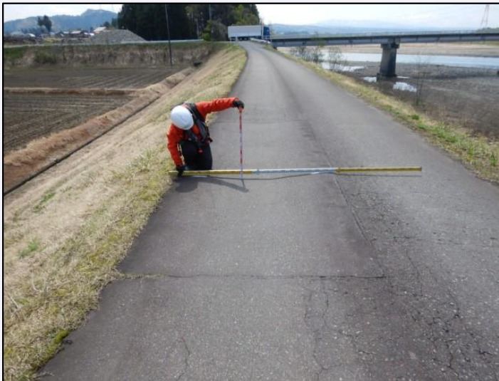
堤防天端の点検（十日町出張所管内）
