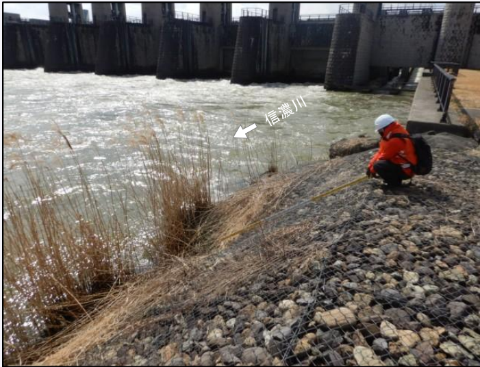
カゴマットの点検（大河津出張所管内）
