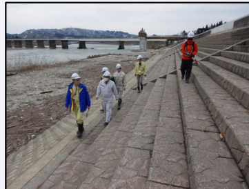
妙見流域治水出張所管内
