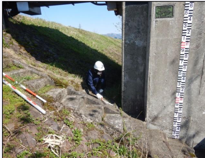
樋管の点検（堀之内出張所管内）
