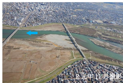
写真 2-4 信濃川 国道351号 長生橋付近 (長岡市)
