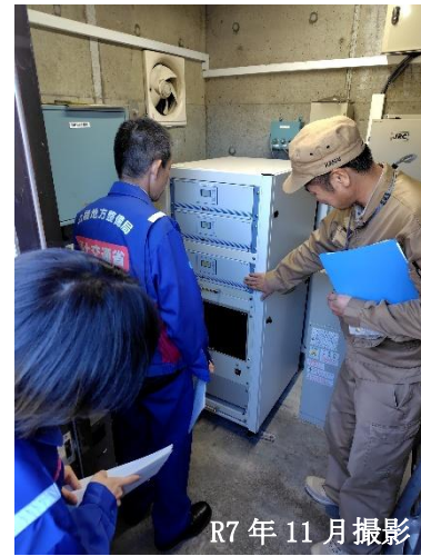
写真 6-3 水文観測所点検 (岩沢水位観測所)
