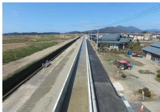
完成写真（終点から起点を望む）
