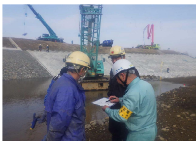
「東北電力による現地確認」
