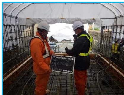
【写真9：打設チェック状況】
