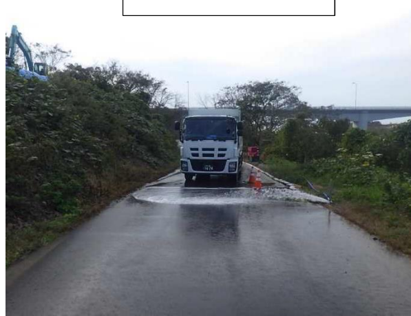
タイヤ洗浄状況
