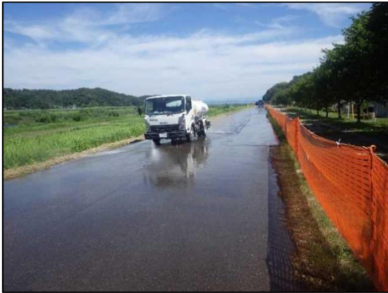
散水車による散水状況
