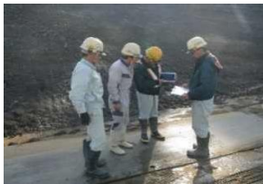
設計データをオペレータと現地で確認
