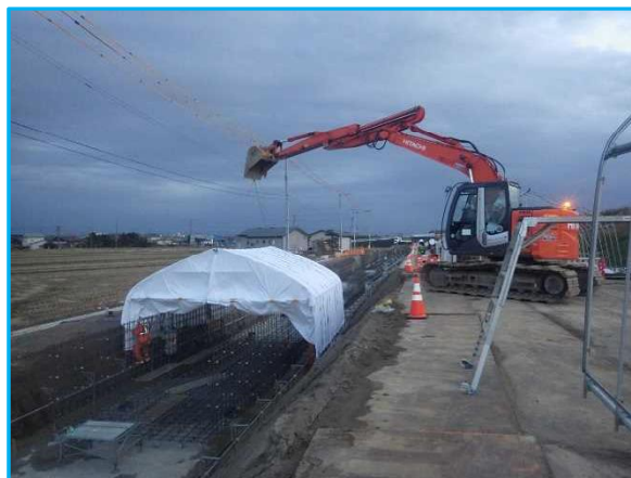
【写真2：養生枠設置状況】
