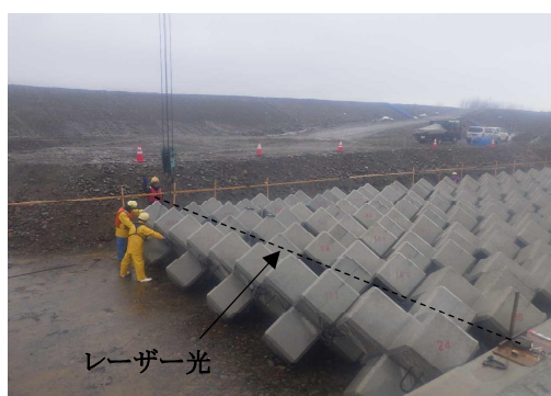
「ブロック据付作業状況」
