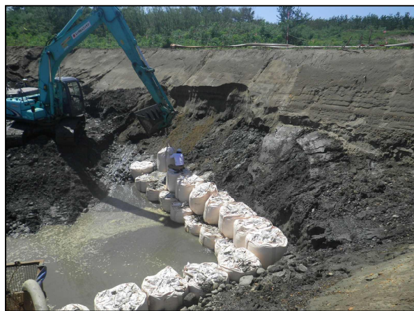
マシンガイダンスバックホウによる 大型土のう設置状況
