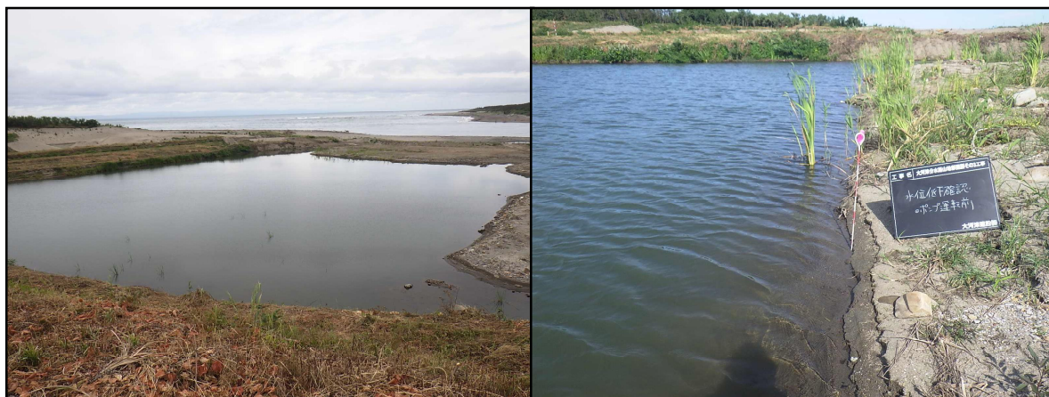
排水試験前現地状況
