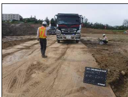
図-10 車両重量計測状況
