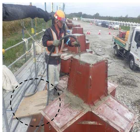
「ブロック打設状況」
