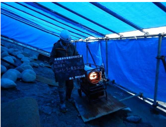
「ジェットヒーター使用状況」
