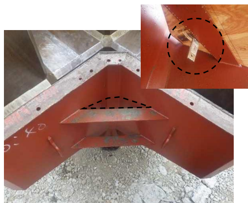
「L型アンクル取付（ズレ止め）」
