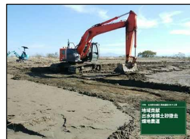
農道の土砂撤去
