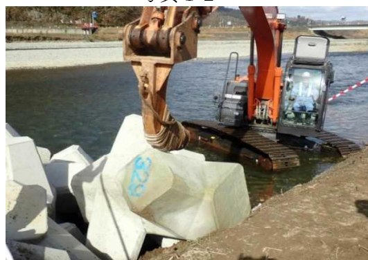
吊下ろし後の不安定な状態でのブロック押さえによる据付固定作業
