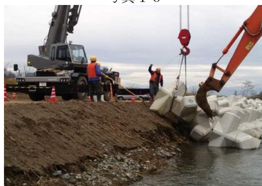
法面でのブロック据付位置の固定補助
