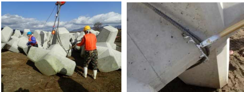
ワイヤーを利かせる作業でノータッチで定位置に固定
