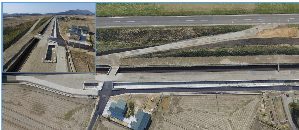
【写真10：三面水路完成写真】
