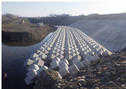
「根固め工完了」
