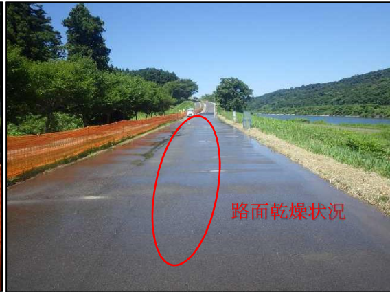
給水時路面状況
