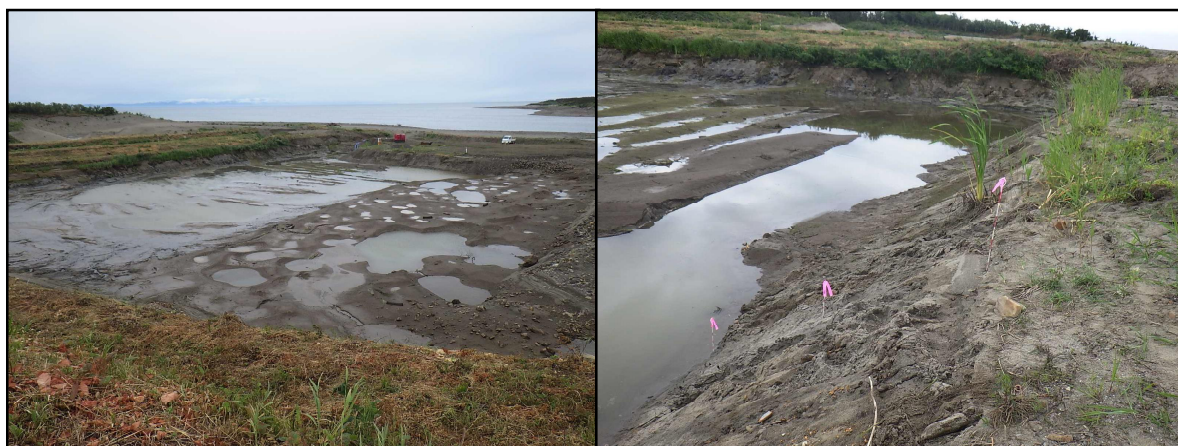
排水試験後現地状況
