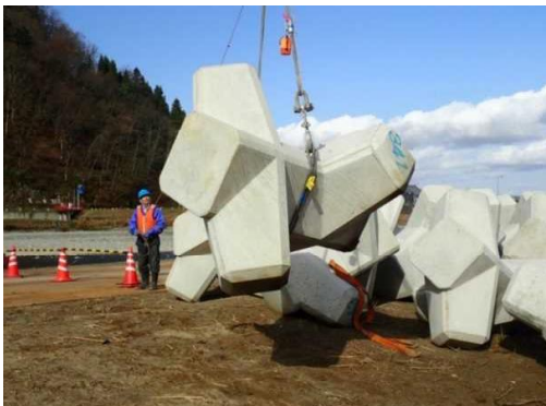
根固めブロック吊荷状況
