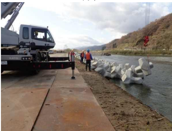
流水部の乱積施工状況
