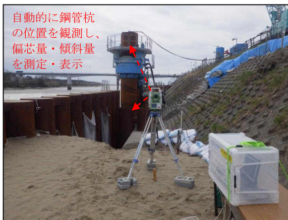
ノンプリズムトータルステーションによる計測状況
