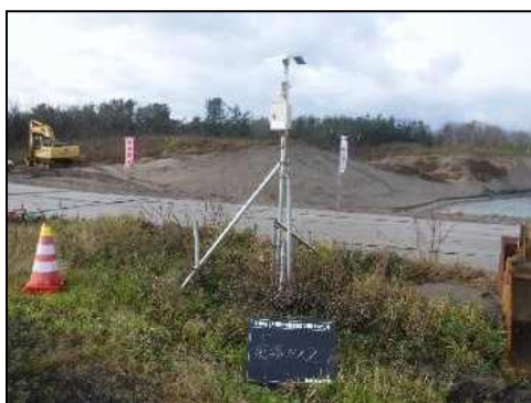
図-14 現場設置カメラ
