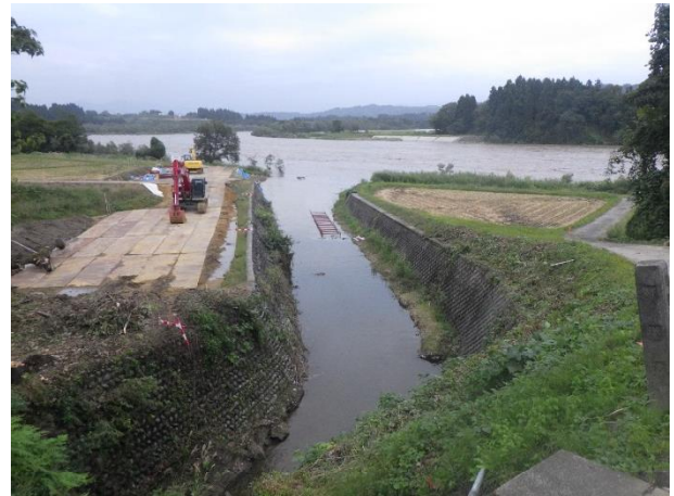
写真-8 悪沢川増水状況
