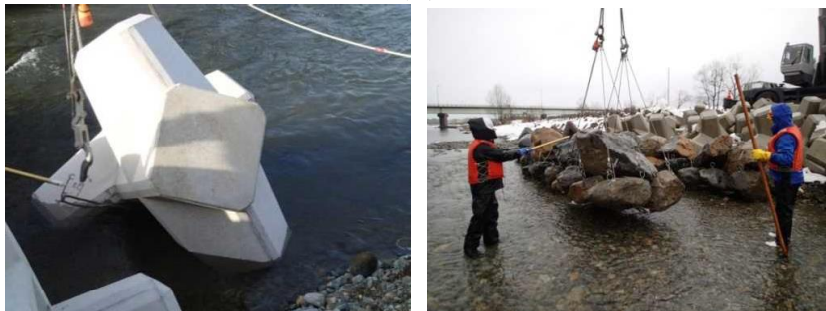
ワイヤー・吊具の絡み・咬み防止
