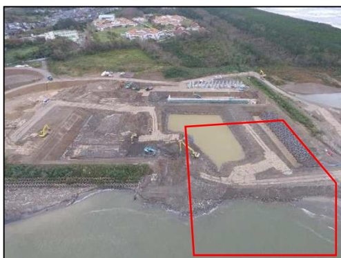
図-2 施工中（平成30年10月撮影）
