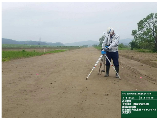
写真 2 現場 CBR 値測定状況
