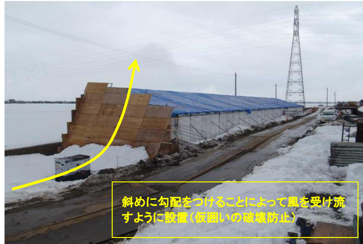
妻部の養生壁設置状況
