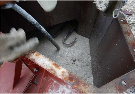
「バイブレーター挿入状況」
