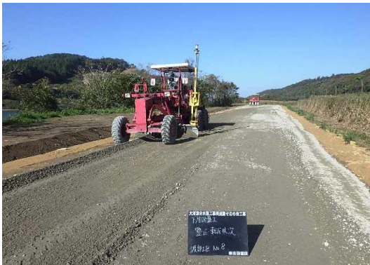
MCグレーダーによる下層路盤整正状況
