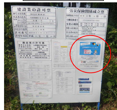
現場出入り口掲示板
