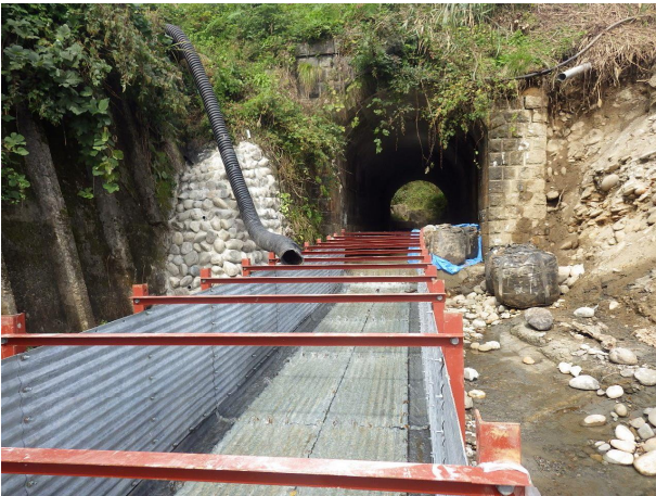
写真-9 コルゲートフリユーム設置状況
