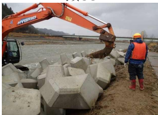
吊下ろし後の不安定な状態でのブロック押さえによる据付固定作業
