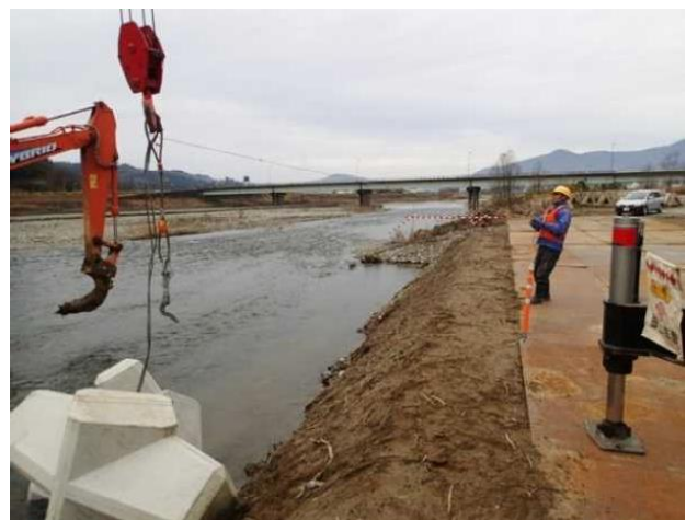
リリースフック解除（ワイヤーの取り外し状況）
