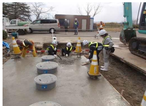
コンクリート均し
