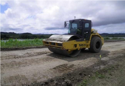
GNSSを用いた転圧管理状況
