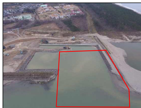
図-3 施工完了（平成31年2月撮影）
