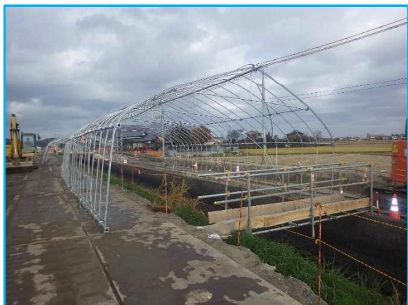
【写真1：養生枠骨組み】
