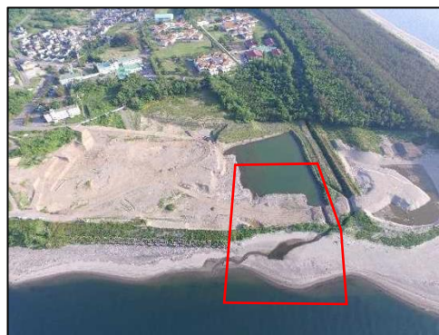
図-1 施工前（平成30年6月撮影）
