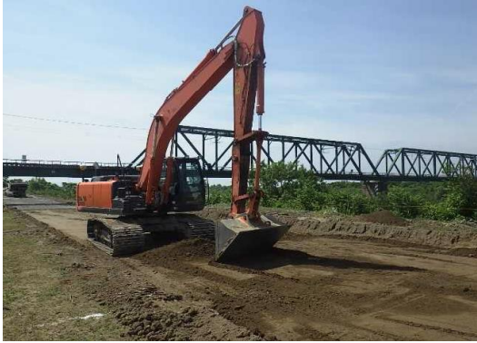
MGバックホウによる整地状況
