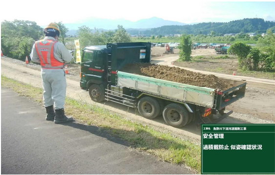
出発時の点検、積荷姿の確認・ タイヤ汚れ泥落としの確認
