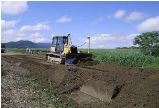
MCブルドーザーによる整地状況
