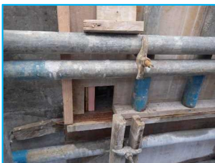
【写真 6：型枠内清掃孔】
