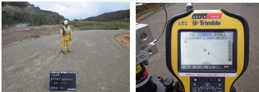
ローバーによる路盤高さ確認
