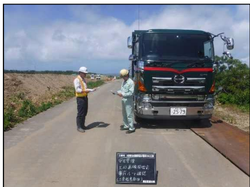
図-4 ダンプトラックによる事前運搬ルート確認
