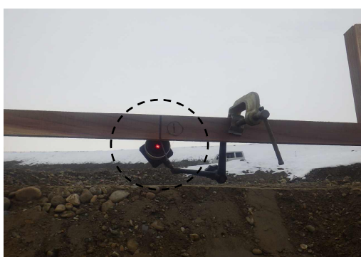
「レーザー装置設置状況」
