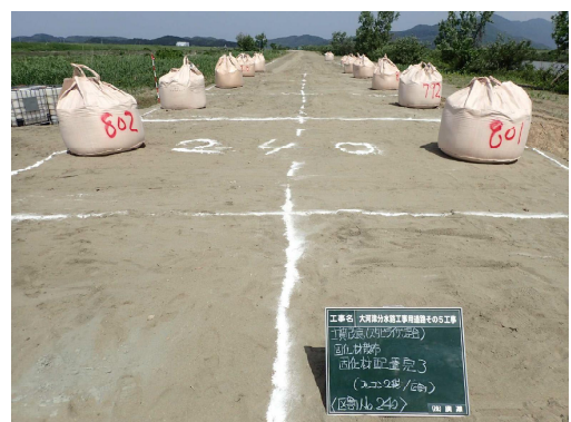
写真 1 固化材散布用区割り設置
