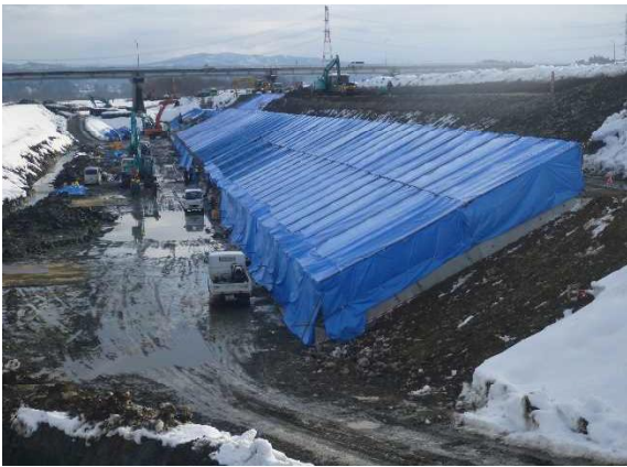
「雪寒仮囲い設置状況」
