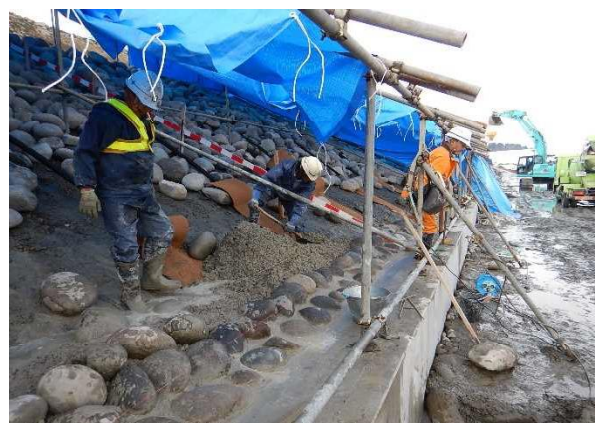
「練石張り作業状況」
