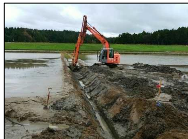
閉塞した排水路復旧
