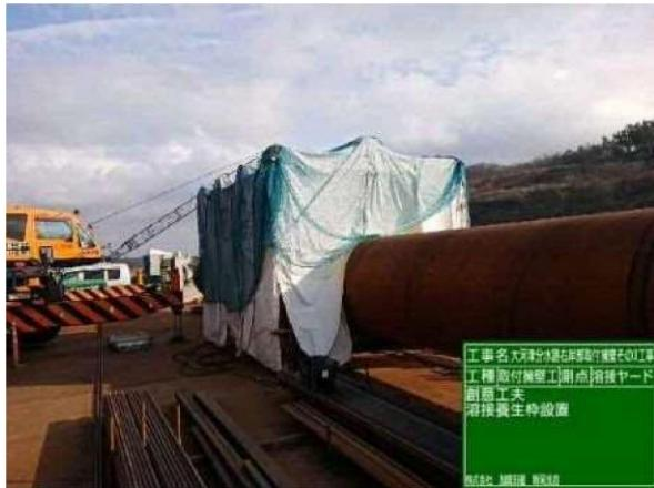
写-3 横縫現場溶接養生枠設置状況
