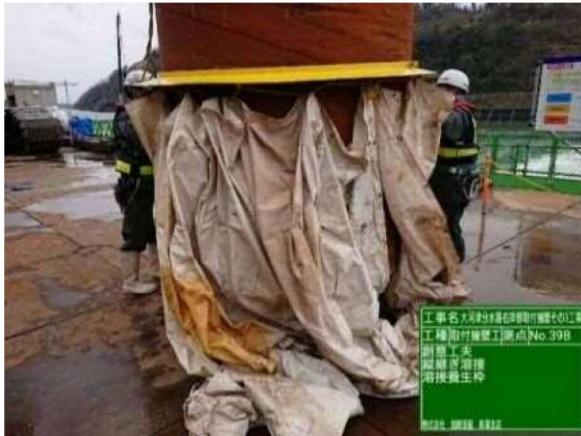
写-5 縦継現場溶接養生ハット設置状況
