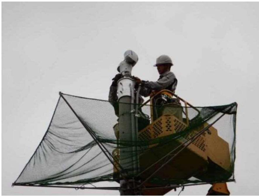
飛来・落下災害防止対策を施した柱上作業
