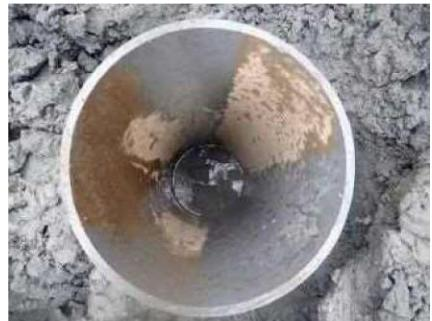
[掘削・清掃後の鋼管杭内部の状況]
