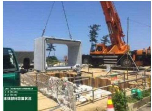
写真-7 防火水槽据付状況
