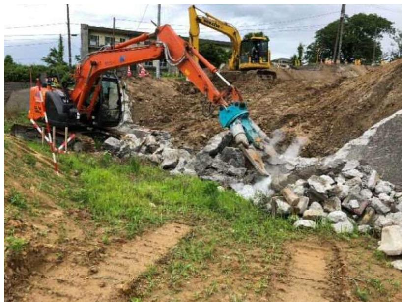
圧碎機によるコンクリート取壊し状況
