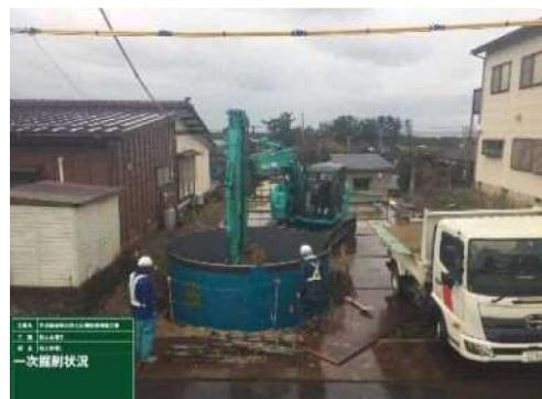
写真-3 潜函掘削状況
