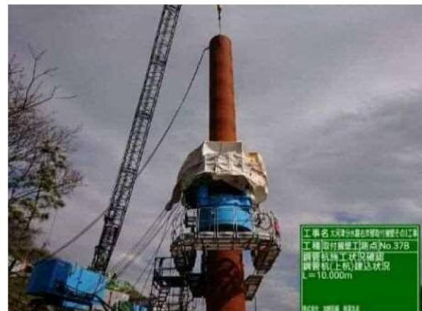
写-6 縦継現場溶接養生ハット設置状況
