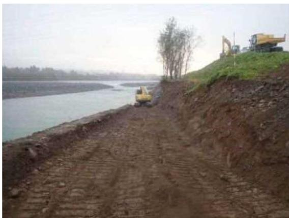
写真-5 袋詰め玉石(2t)設置状況
