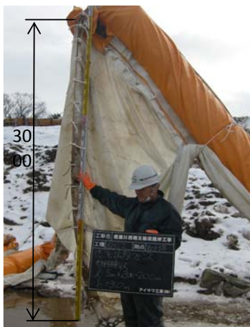
汚濁水拡散防止フェンス H=3000
