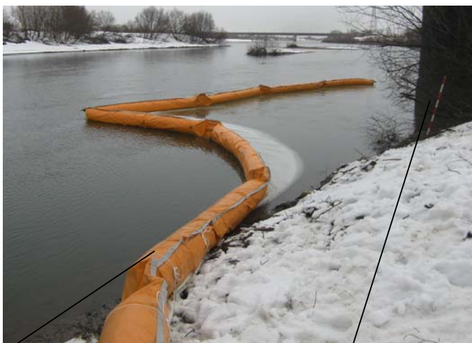
汚濁水拡散防止フェンス 完了全景 H=3000 40mm
