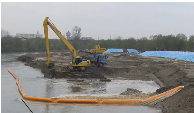
(写真3) 掘削箇所
