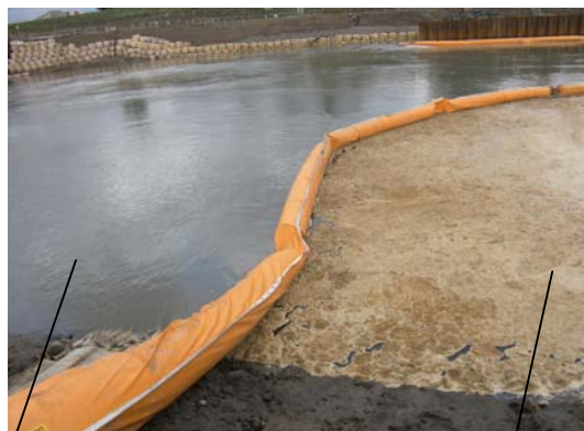
汚濁水拡散防止フェンス 外側 汚濁水拡散防止フェンス 内側
