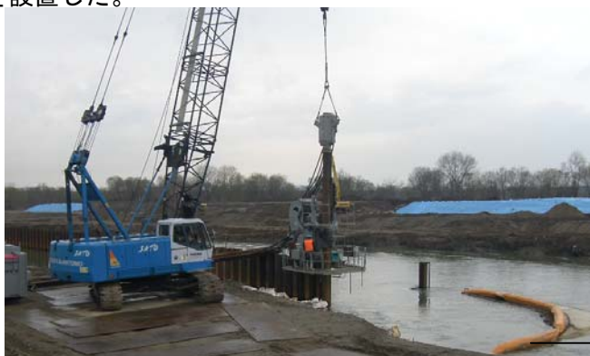
汚濁水拡散防止フェンス 完了全景 H=3000 20m
