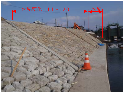
練石張 施工完了 (No. 6)
