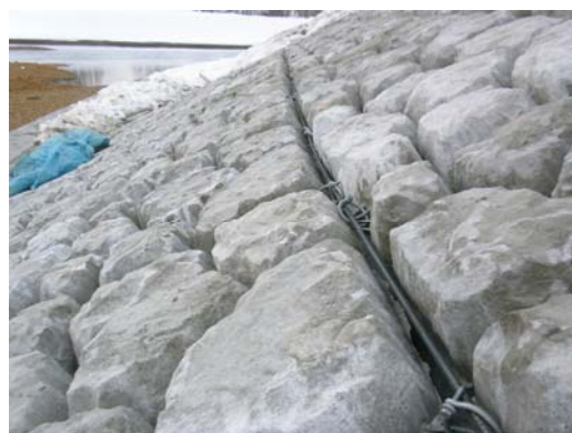
延長方向・通し鉄筋施工状況
