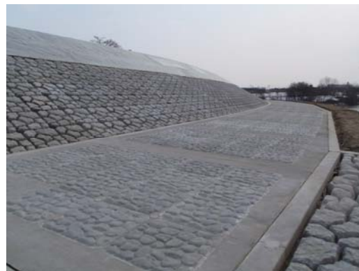
連結ブロック ( 1 m^2 / 枚) 施工完了 (変化の少ない区間)
