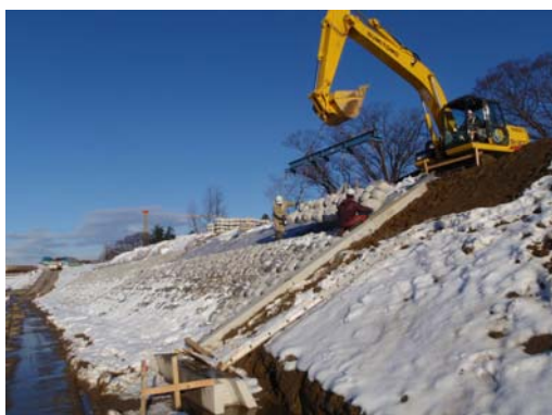
連結ブロック・4m2/枚 施工状況
