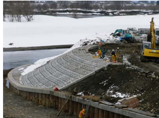
連結ブロック張完了 (R = 5.4 ~ 6.7 m)
