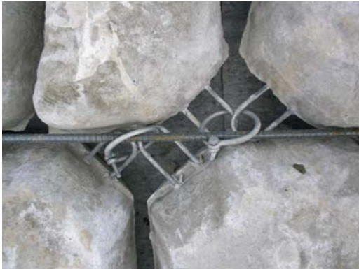
通し鉄筋によるブロック連結状況
