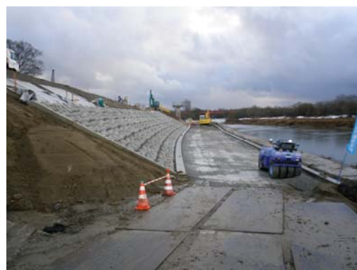
施工完了・4m2/枚（No.1）
