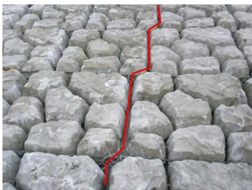
連結ブロック縦目地ずらし状況
