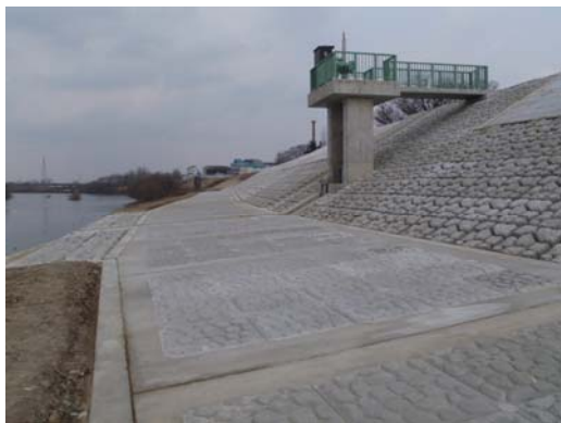
連結ブロック ( 1 m^2 / 枚) 施工完了 (変化の少ない区間)
