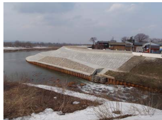
法覆護岸施工完了 (最上流部より望む)
