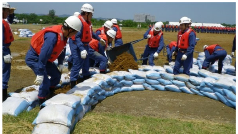
水防工法(月の輪工法)
