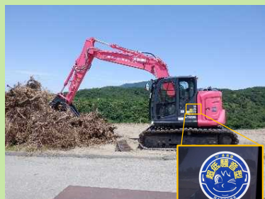
低騒音型建設機械の採用
