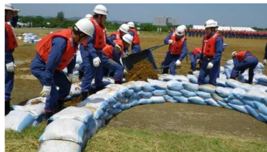
水防工法(月の輪工法)
