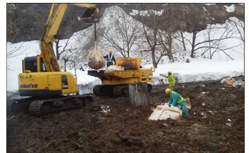
油が浸透した土砂の撤去作業
