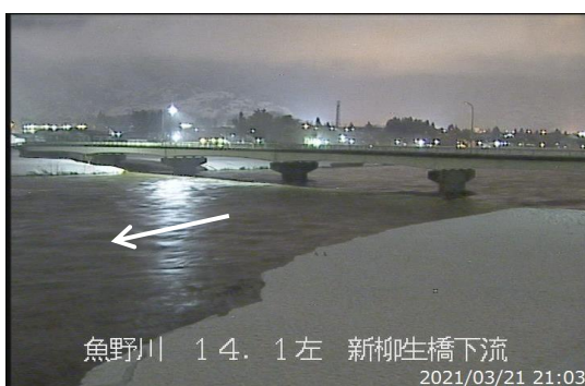
出水時 (2021/03/21 21:03 新柳生橋下流)
