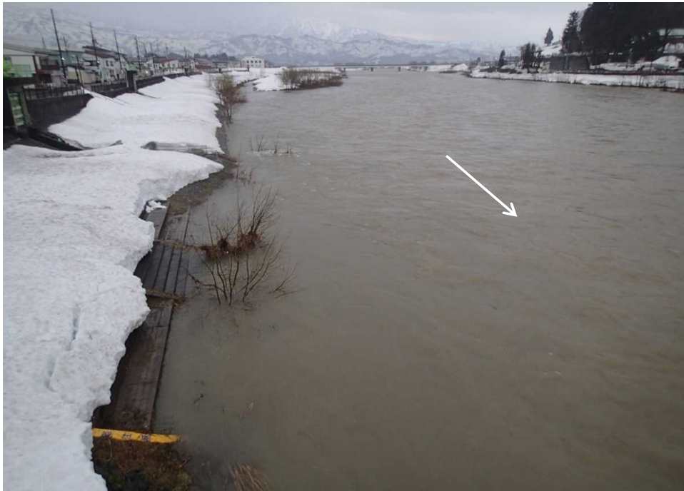
小出橋右岸側より魚野川上流の状況(22日 6時23分撮影)
