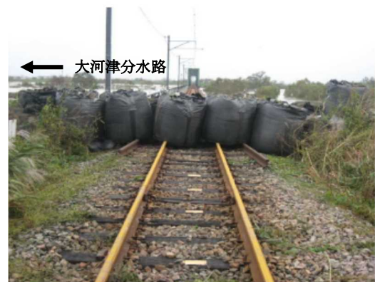
積土のう工実施状況(左岸側)
