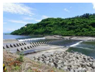
第二床固(河口)
