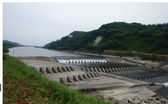
大河津分水路 第二床固 （下流から望む）
