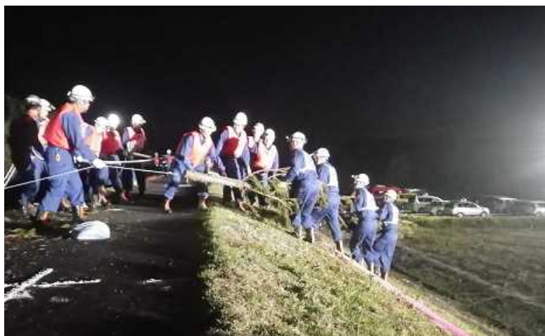
平成29年度 実施の様子（木流し工）
