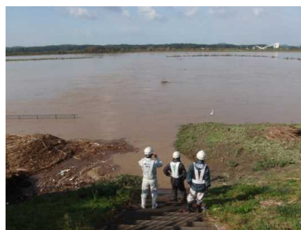
10月24日11時頃 大河津分水路 大河津可動堰上流付近
