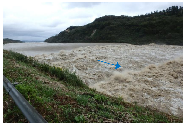
大河津分水路 下流より第二床固めを望む 10月23日 14時頃
