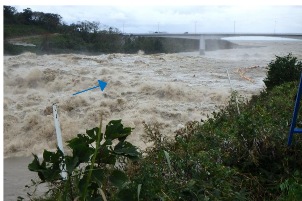
大河津分水路 上流より野積橋を望む 10月23日 14時頃
