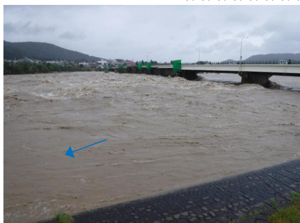
信濃川 下流より旭橋を望む 10月23日11時頃
