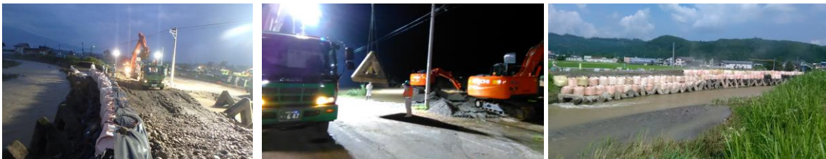
三用川堤防決壊箇所の応急復旧工事（照明車、異形コンクリートブロックの使用状況）
