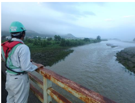
福山橋(魚沼市青島)付近巡視状況
