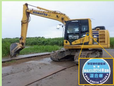
排出ガス対策型 建設機械の採用
