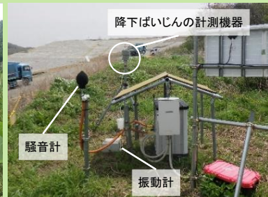
モニタリング計測機器の 設置状況
