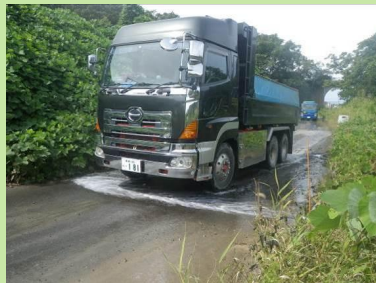
工事用車両の タイヤ洗浄状況
