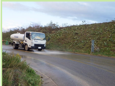
工事用道路への散水状況
