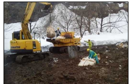
油が浸透した土砂の撤去作業。
