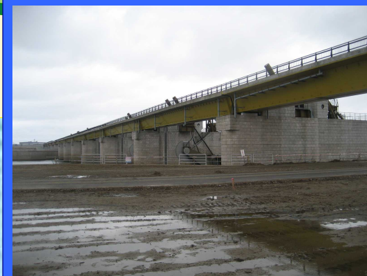
① 左岸仮締切りより
