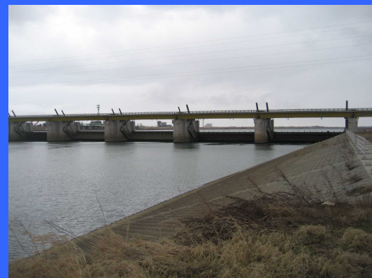
④ 左岸魚道下流より
