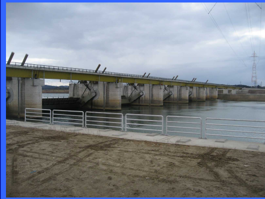
③ 右岸仮締切りより
