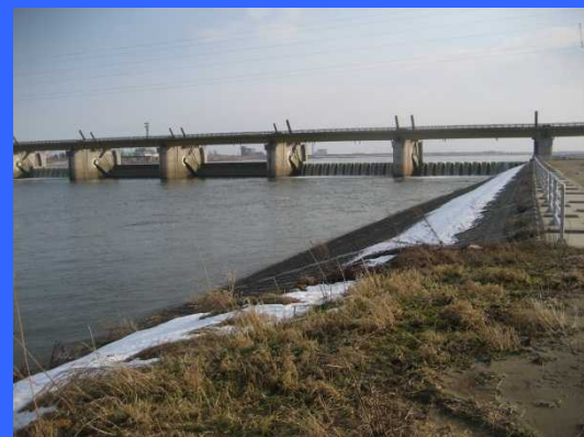
④ 左岸魚道下流より
