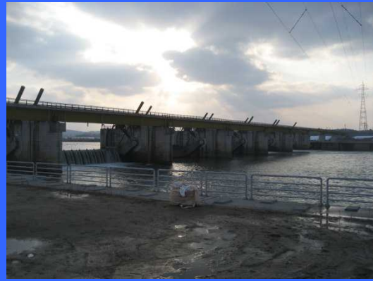
③ 右岸仮締切りより
