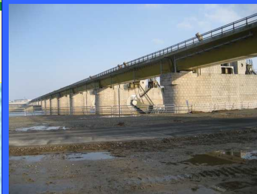
① 左岸仮締切りより
