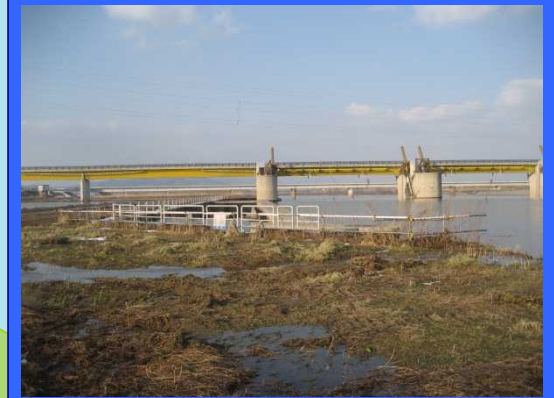
② 左岸魚道上流より
