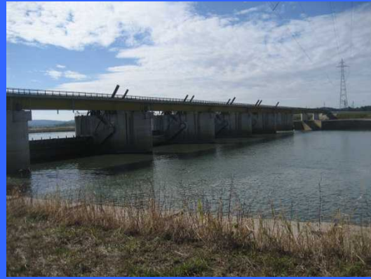
③ 右岸仮締切りより
