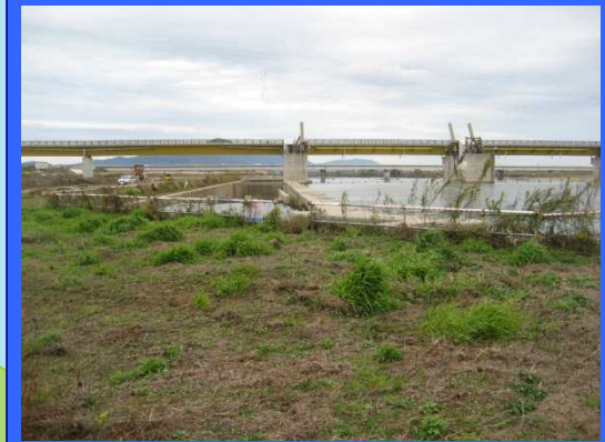
② 左岸魚道上流より
