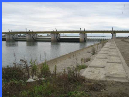
④ 左岸魚道下流より
