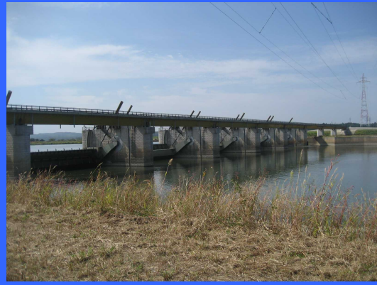
③ 右岸仮締切りより
