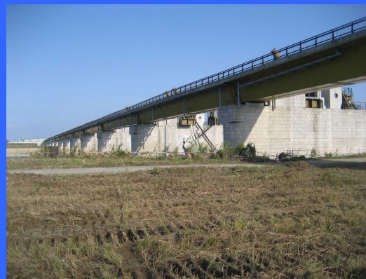
① 左岸仮締切りより
