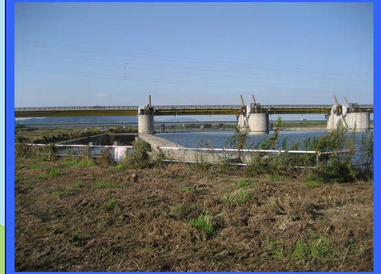
② 左岸魚道上流より
