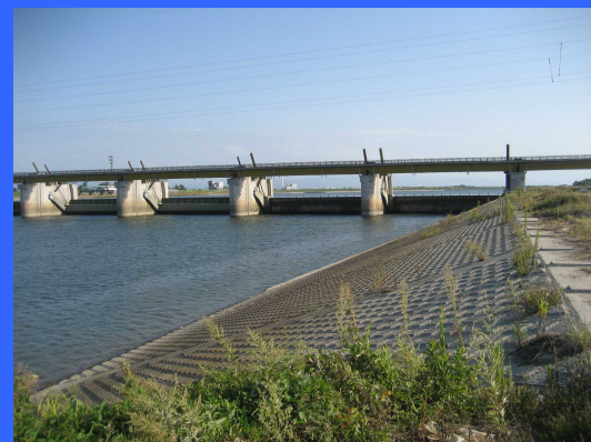
④ 左岸魚道下流より
