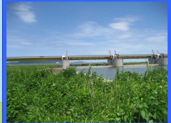
② 左岸魚道上流より
