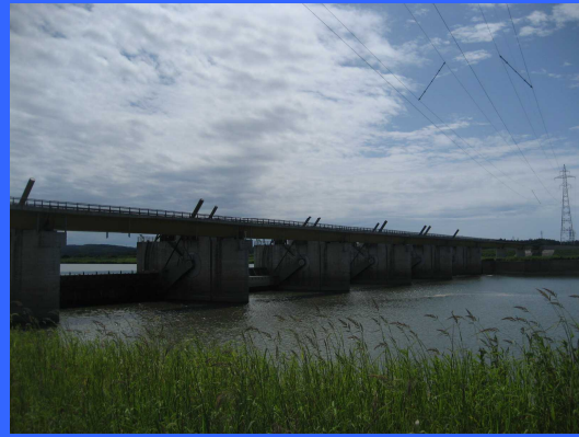
③ 右岸仮締切りより
