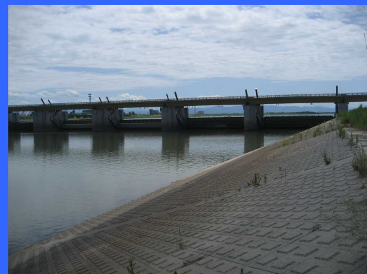
④ 左岸魚道下流より
