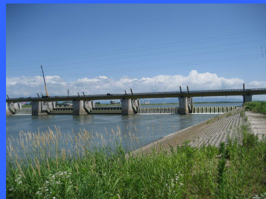
④ 左岸魚道下流より
