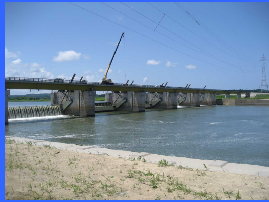
③ 右岸仮締切りより
