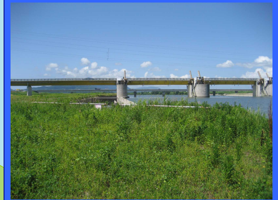
② 左岸魚道上流より
