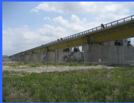
① 左岸仮締切りより
