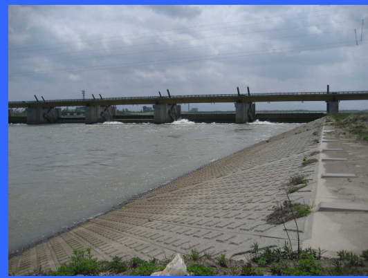
④ 左岸魚道下流より
