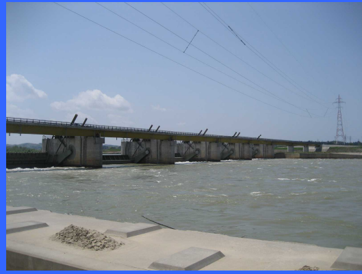
③ 右岸仮締切りより
