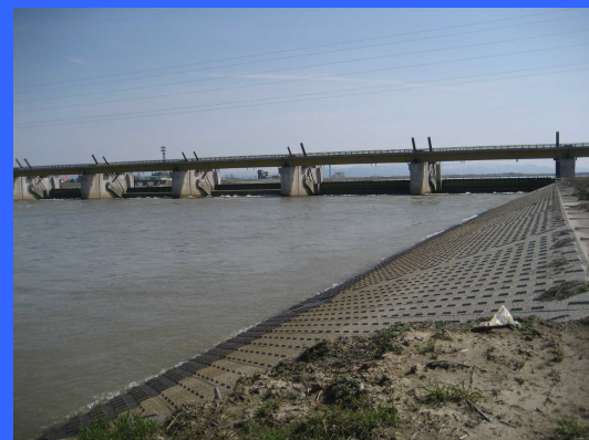
④ 左岸魚道下流より
