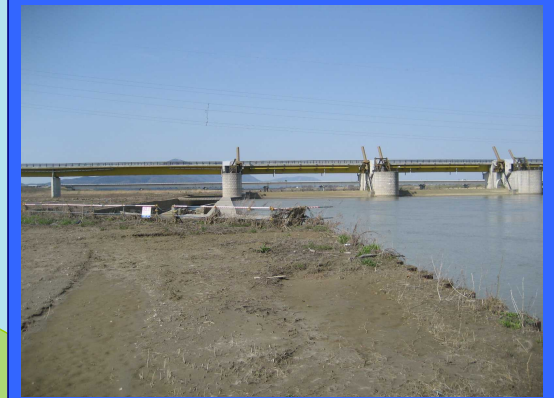
② 左岸魚道上流より
