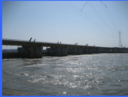
③ 右岸仮締切りより
