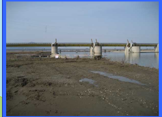
② 左岸魚道上流より
