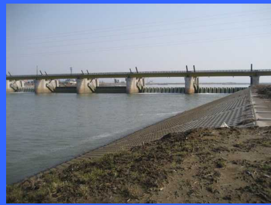
④ 左岸魚道下流より
