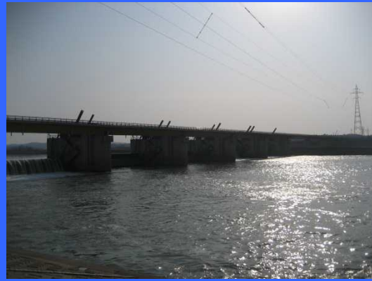
③ 右岸仮締切りより
