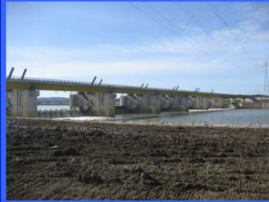
③ 右岸仮締切りより
