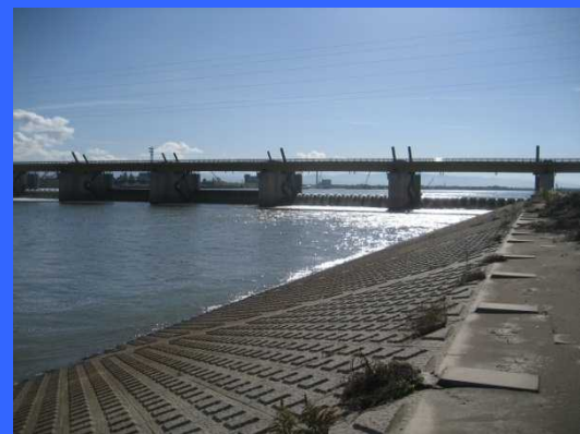
④ 左岸魚道下流より
