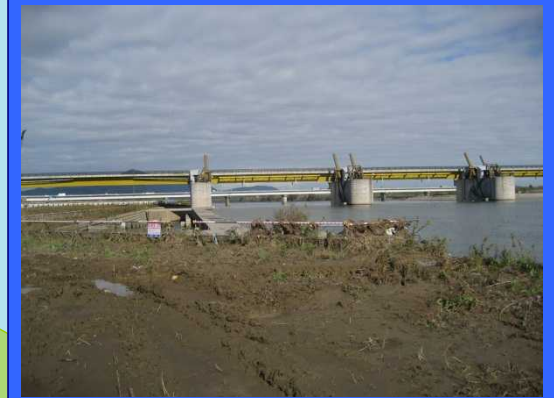
② 左岸魚道上流より
