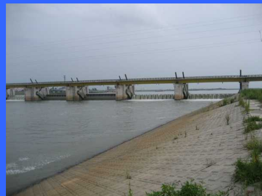
④ 左岸魚道下流より
