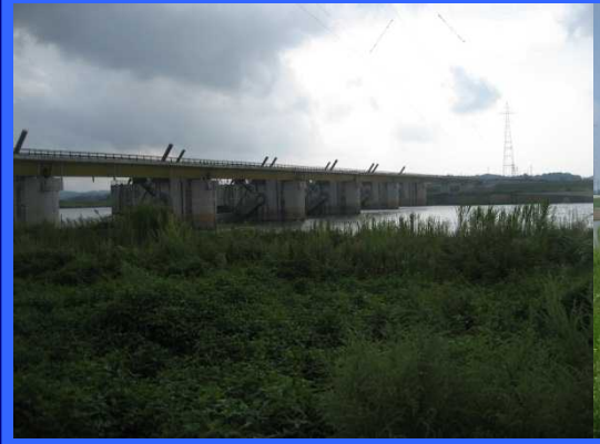
③ 右岸仮締切りより
